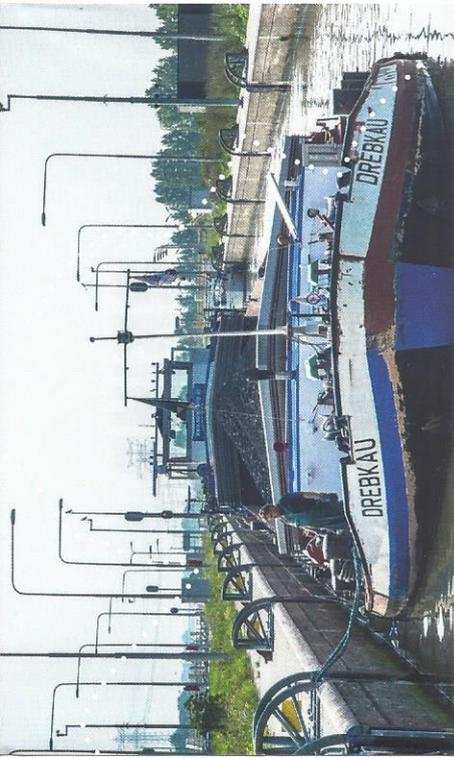
**6 Schleusen und Leitstelle des Wasserwirtschaftsamts "Rijkswaterstaat"** - drei Schleusenkammern, die einen Niveauunterschied von fast 12 Metern überbrücken.
