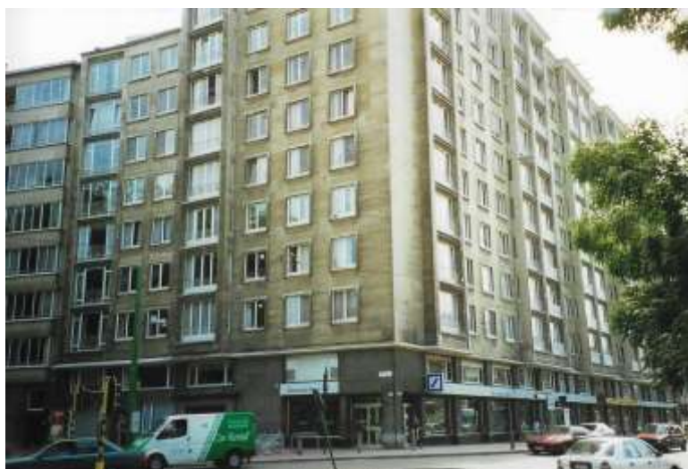
Appartementsgebouw hoek Prins Albertlei-Generaal Lemanstraat 3
