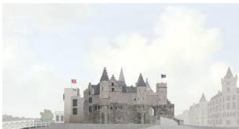
Het Steen van Antwerpen na renovatie in 2021
