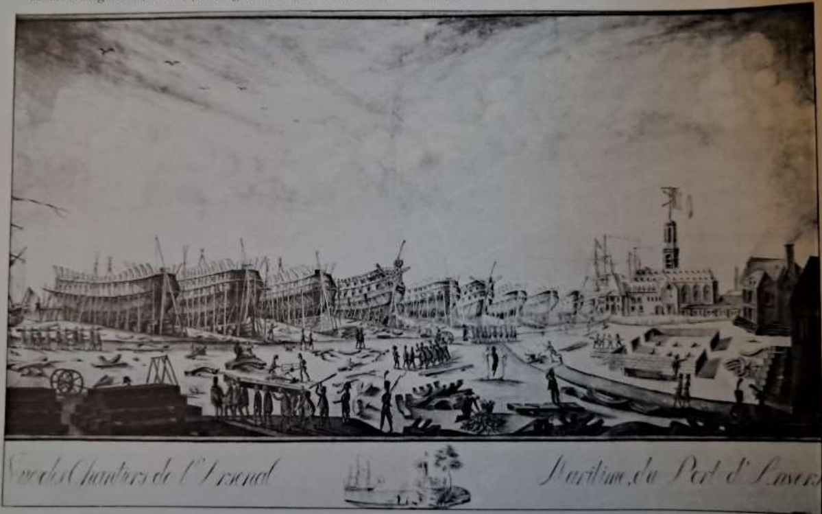
3. Gezicht op de constructie van de linijschepen. Op de toren van de St.-Michielsabdij werd een semafoor aangebracht, na 1807 (tekening, Kon. Bibl. Albert I, Prentenkabinet, E4c).
