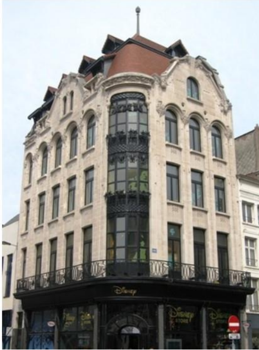
Hoekgebouw Meir-lange Klarenstraat in art nouveau
