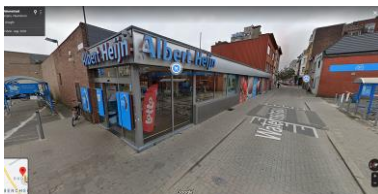
Foto 23 Momenteel parking en supermarkt Albert Heijn
