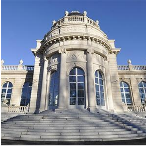
Tentoonstellingsgebouw 'La Boverie' te Luik
