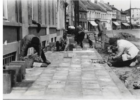
de aanleg van een nieuw voetpad rond 1927. Een slijpschijf bestond nog niet. De dals werden op maat met de hand gekapt. Op de hoek met de Bronstraat was ook een herberg waar soep werd gemaakt voor de werknemers van Minerva.
